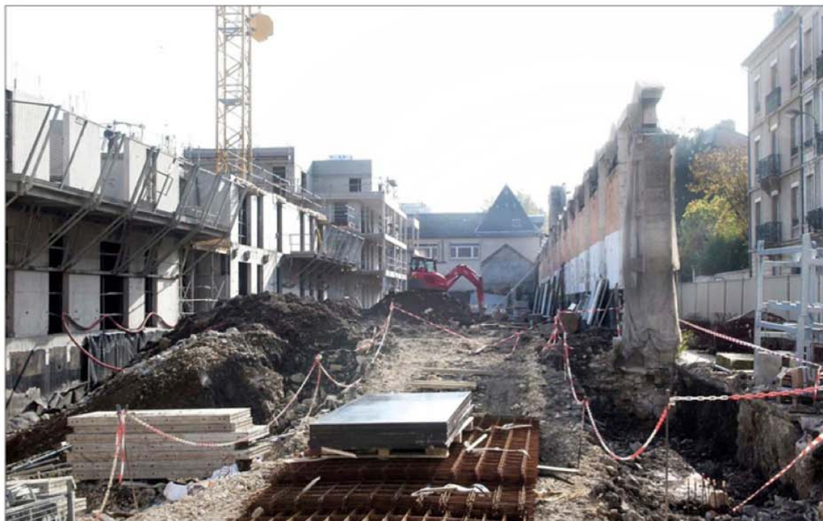
■ Les travaux avancent à grands pas sur l'ancien site Berger-Levrault.
