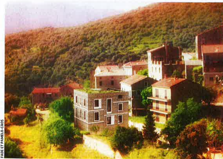
Marie Fade et Alice Pamela-Gros ont imaginé un cube de pierre bâti en utilisant la technique économique du gabion. Un patio central oriente l'organisation des pièces.
